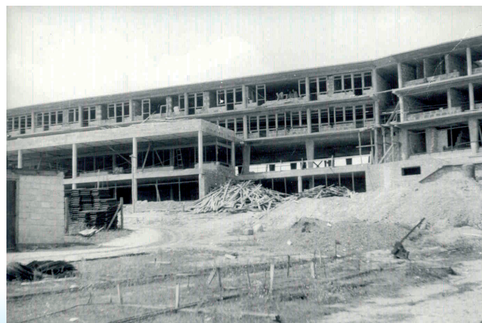
Ośrodek Narew w trakcie budowy
