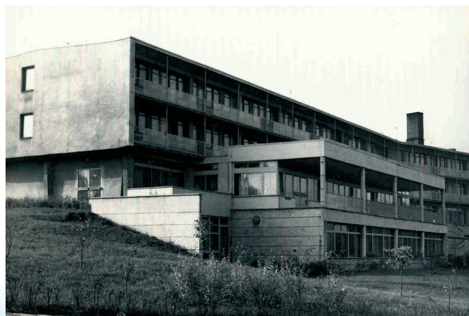
Ośrodek Narew wschodnia elewacja
